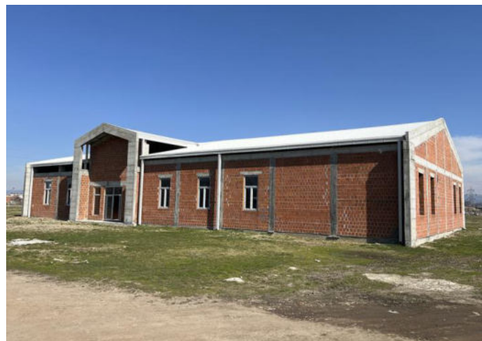
Slika 97. Verski hram „Zajednice Roma” iz Leskovca u izgradnji (mart 2025)
