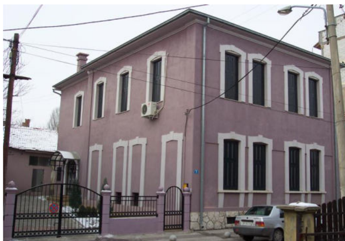
Slika 40. Zgrada Jehovinih svedoka u Nišu (decembar 2008)
